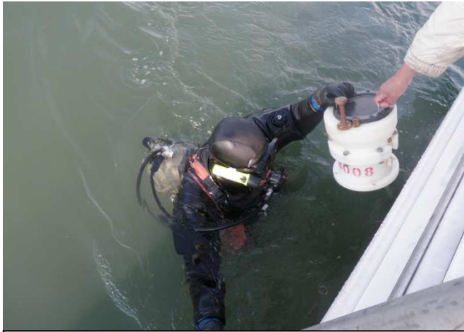
Instalação do Equipamento de Medição
