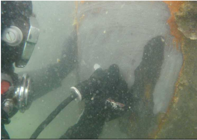
Medição de Espessura de Placa de Aço de Murada
